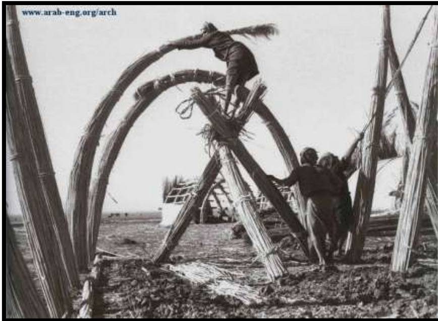
(صورة ١٠) بناء الصريفة حاليا في جنوب العراق ، والصورة توضح عملية ثني حزم القصب لتشكيل الهيكل
